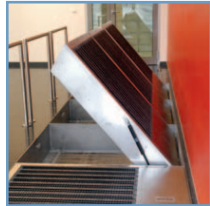
Rengöring är enkelt eftersom gasfjädrar hjälper till att öppna enheten Cleaning is made easy due to gas struts which open the gate effortlessly
